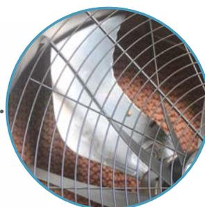
Para asegurar este proceso, el agua contenida en el el tanque de 200L es bombeada y redistribuida en paneles de evaporación. Mientras fuera el aire caliente pasa a través de paneles, renovados y redistribuido gracias al ventilador con capacidad de 17.000 m<sup>3</sup> / h.
